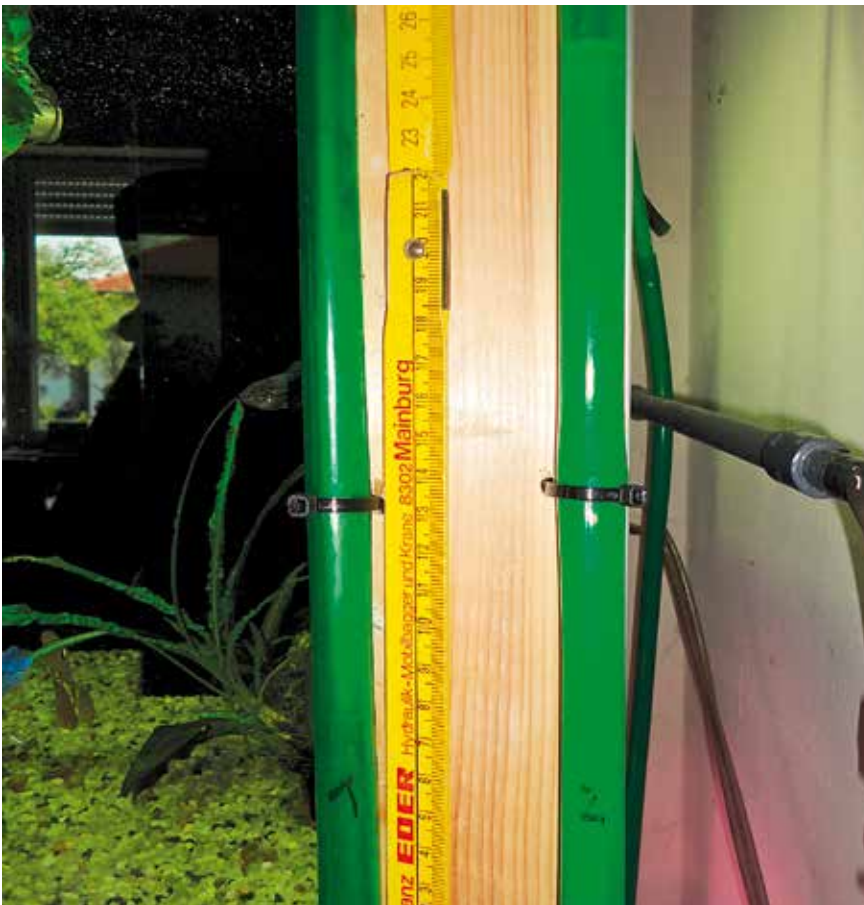
U-Rohr-Manometer an der großen Aquarienanlage, der gemessene Druckabfall: zweimal 25 Zentimeter Wassersäule, also 0,05 Bar
