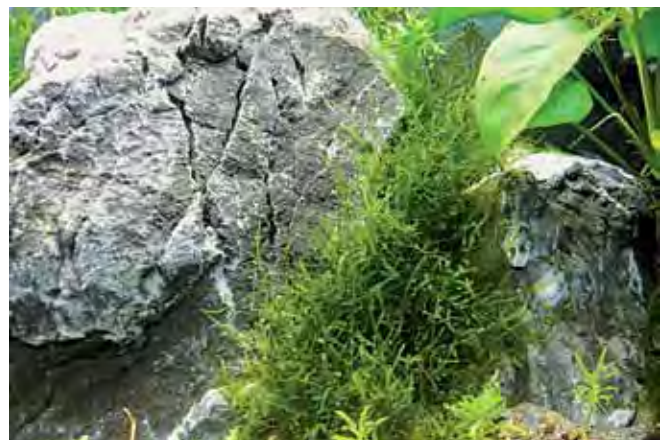
Böschung nach einem Monat
